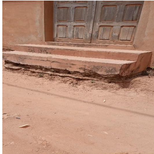
Planche 1 : Poteau électrique déchaussé par l'érosion à Gbétagbo (à gauche) et déchaussement d'un système de protection par l'érosion à Akassato (à droite) ( Prise de vues : Eténé, janvier 2022 )
