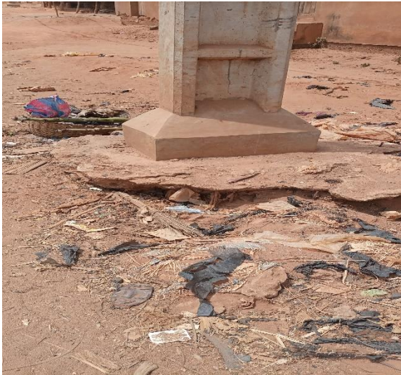
Planche 1 : Poteau électrique déchaussé par l'érosion à Gbétagbo (à gauche) et déchaussement d'un système de protection par l'érosion à Akassato (à droite) ( Prise de vues : Eténé, janvier 2022 )
