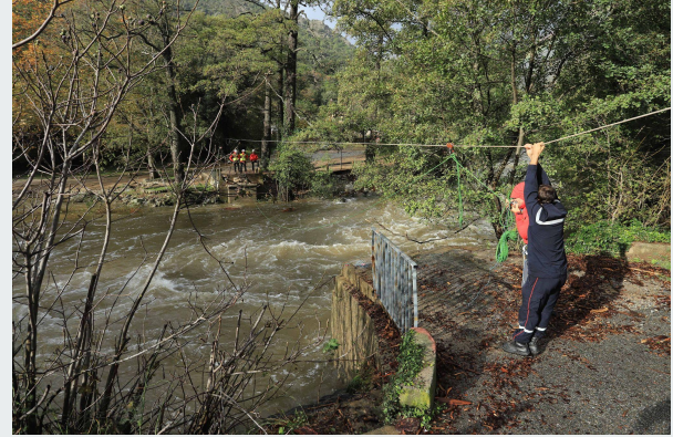
Pont de baliri après une crue soudaine le 04/11/2023, Corte Source : https://www.corsenetinfos.corsica/
