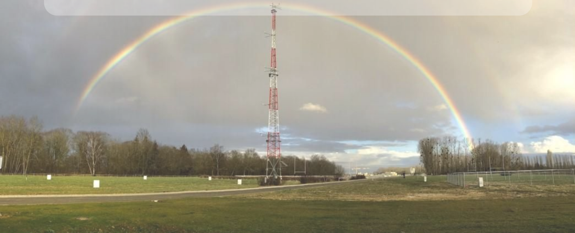
Mât de mesures météorologiques du SIRTA (banlieue parisienne)
