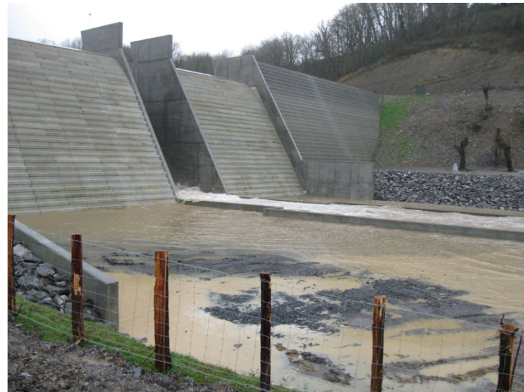
Barrage écrêteur de Lurberria (Saint-Pée-sur-Nivelle)
